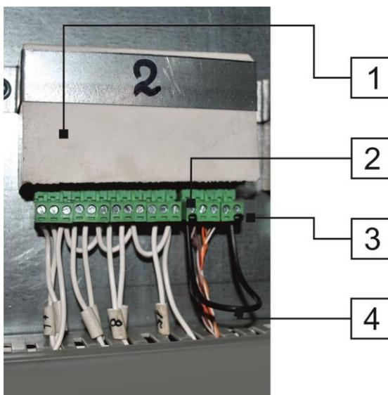
Рис. 25. Установка перемычки на сменный распределительный модуль.
